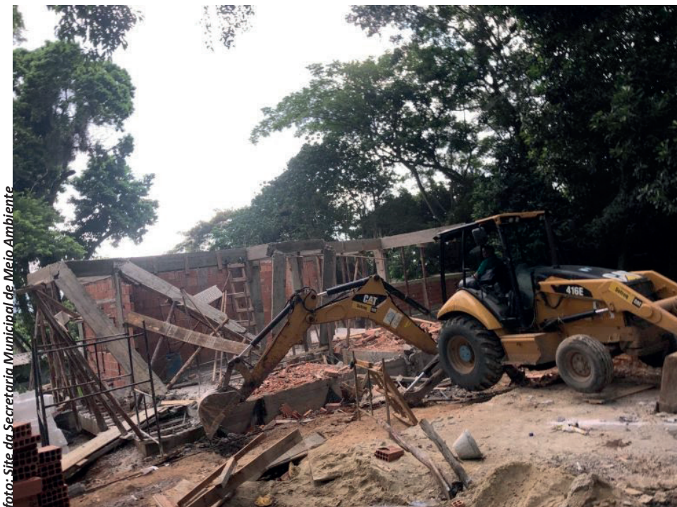
Casa em construção em área ambiental sendo destruída
